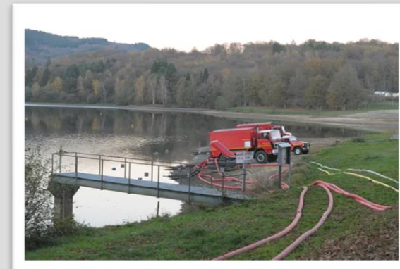
L'incident lié à la digue en 2015 avait impliqué le report du projet et de coûteux travaux de réfection des ouvrages, comme la digue
